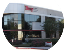
Installation de recherche et développement États-Unis
