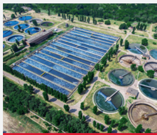
EAU ET EAUX USÉES
