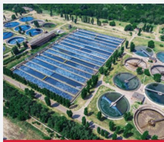
WASSER UND ABWASSER
